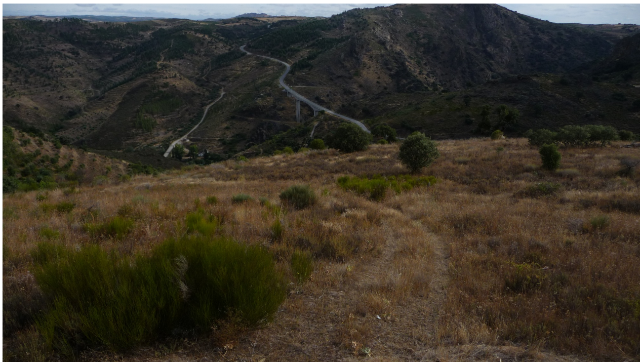
Fig. 2 – Perspectiva sobre a área para onde está projectado o troço enterrado do ramal de ligação à rede eléctrica nacional e da zona de implantação do primeiro apoio à superfície, em primeiro plano.
